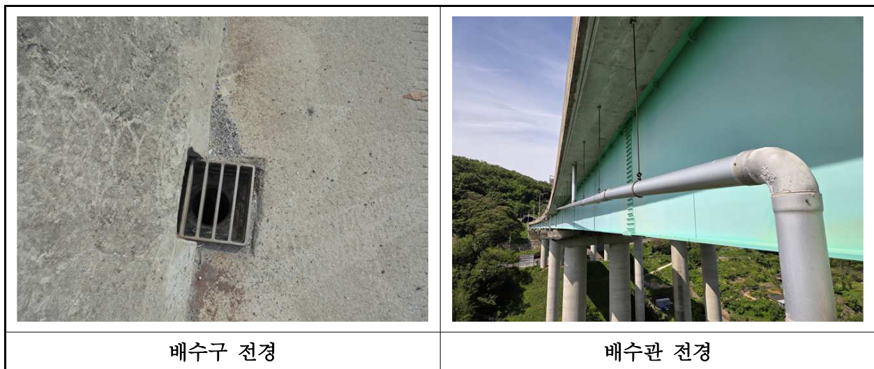
【사진 20.3.24】 배수시설 전경
