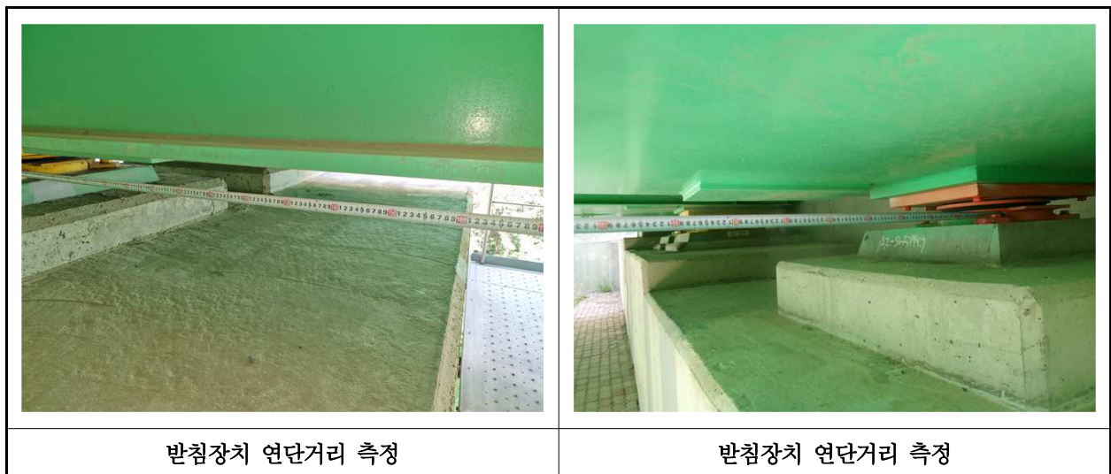
【사진 20.3.17】 교량받침장치 연단거리측정
