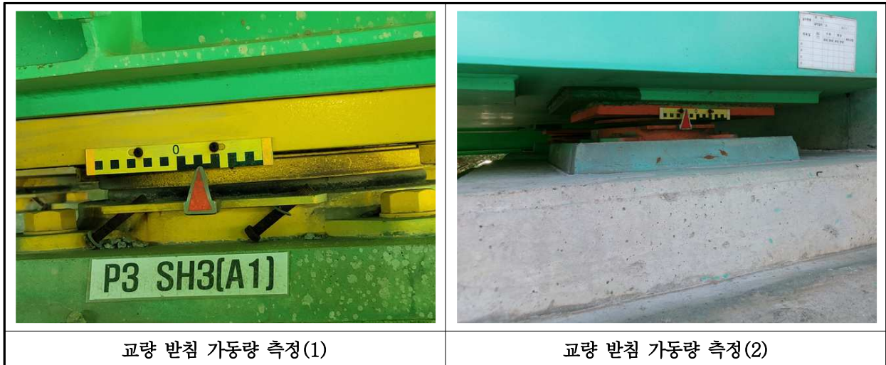
【사진 20.3.18】 교량받침 이동량 측정
