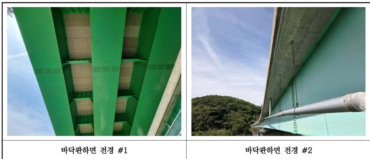
【사진 20.3.2】 바닥판하면 전경
