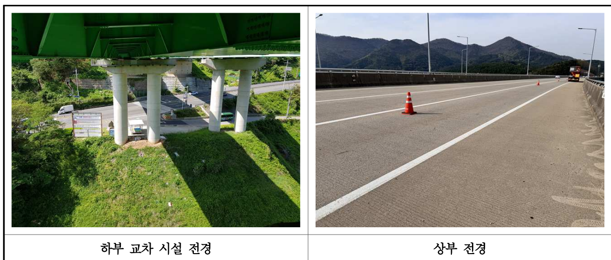
【사진 20.2.1】 주변환경 및 하중변화 전경
