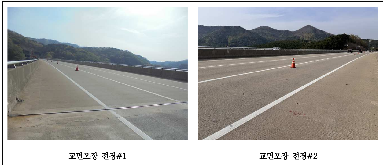
【사진 20.3.22】 교면포장 전경
